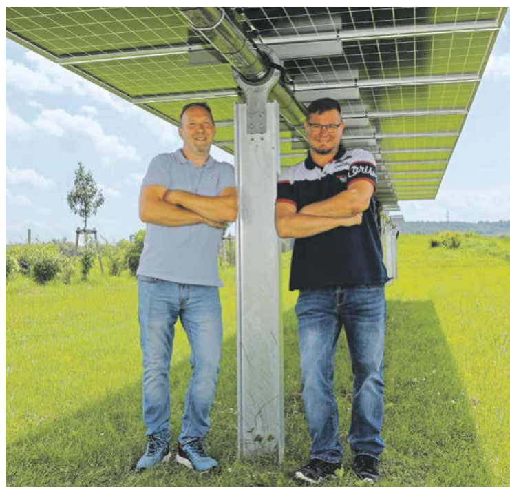
Bewegliche Solarmodule in der richtigen Höhe. Thomas Rakow und Norman Höhne (v. l.) unter ihrem einachsigen Trackersystem.
